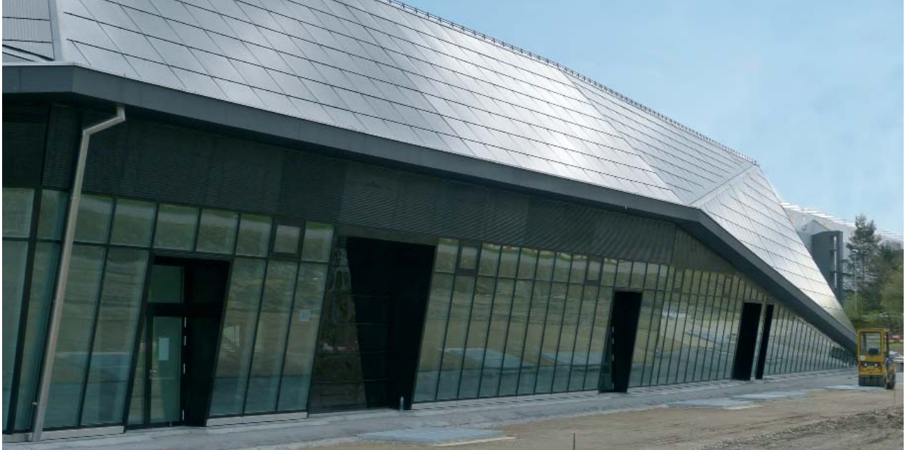
Diese eigenwillige Hallenkonstruktion beinhaltet ein Solardach, das parziell auch die Fassade bildet. Inwieweit auch die geneigten Fensterflächen für Vögel günstig sind, weil sie nur den Boden spiegeln, ist nicht abschliessend geklärt.
