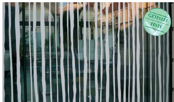
Lineare Markierungen bilden einen bewährten Schutz. Kristallfarbene Folie hebt sich meist gut vom Hintergrund ab.
