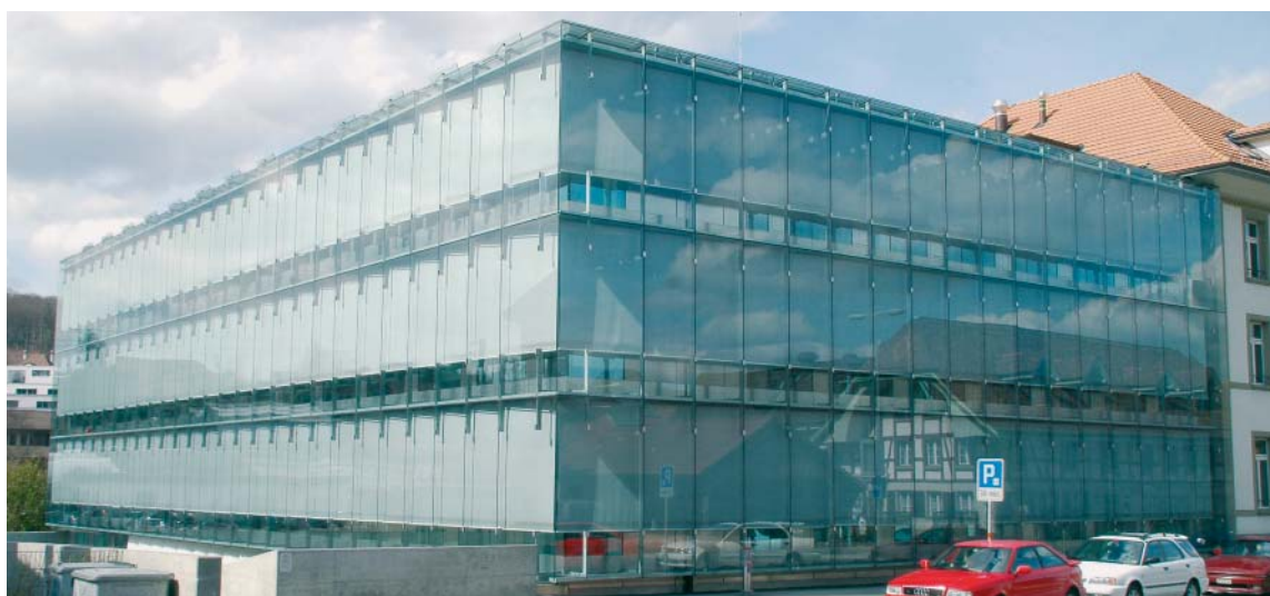
In Glasfassade inwendig integriertes Beschattungssystem. Die Spiegelung ist zwar nicht völlig reduziert und sie wird durch den Aufnahmewinkel sogar noch etwas verstärkt. Trotzdem hält sie sich dank des hellen Stoffes einigermaßen in Grenzen.
