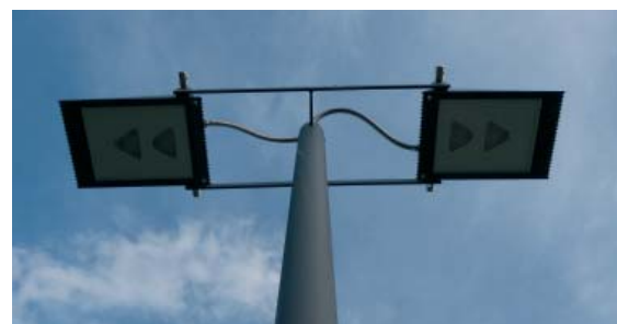
Moderne LED-Scheinwerfer fokussieren Licht auf die gewünschten Bereiche, z.B. auf den Fussgängerstreifen.
