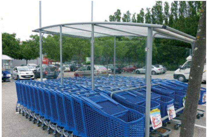
An diesem Unterstand für Einkaufswagen stellen die fast nicht erkennbaren Plexiglaswände eine Gefahr dar.
