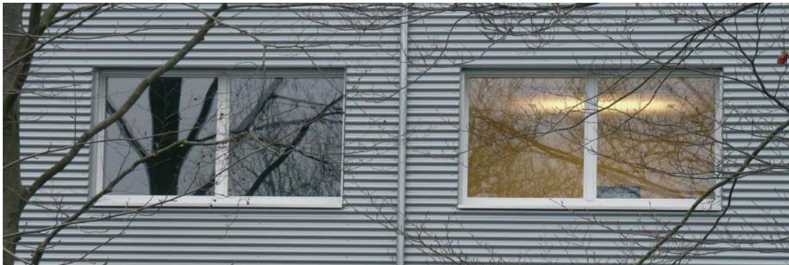
Die Spiegelung hängt von verschiedenen Faktoren ab, so von der Innenbeleuchtung. Derselbe Glastyp spiegelt umso stärker, je dunkler der Hintergrund ist.
