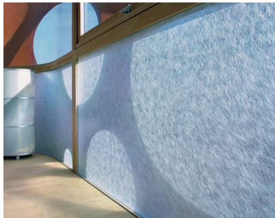
Eine bereits mehrfach ausgezeichnete Innovation sind auf Scheiben selbsthaftende Textilien. Bei Bedarf können sie jederzeit rückstandslos entfernt oder umplatziert werden.
