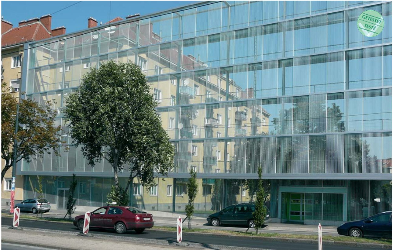
Diese Lärmschutzwand am Theodor-Körner-Hof in Wien wurde 2009 errichtet, um das lärmgeplagte Wohnquartier zu schützen und aufzuwerten. Es ist ein Musterbeispiel für vorbildlichen Vogelschutz, zumal die aufgebrachten Strukturen zuerst im Flugkanal getestet wurden und dort mit ihrer sehr hohen Erfolgsquote überzeugten.
