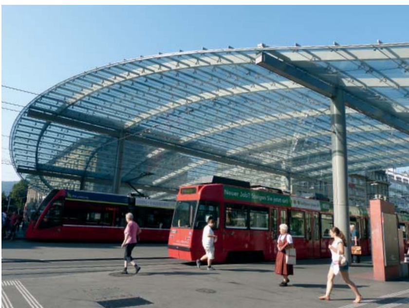
Solche gläserne Überdachungen sind weitgehend unproblematisch. Ein Restrisiko besteht möglicherweise an den Rändern, die stärker geneigt sind. Dank einem flächigen Punktraster, der zudem den Passanten einen gewissen Blendschutz bietet, ist auch diese Gefahr behoben.
