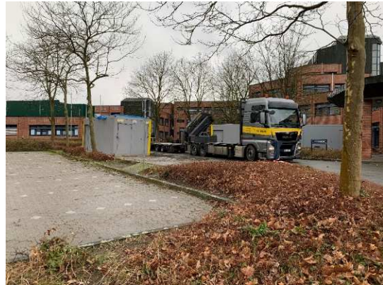
Abbau der Containerbüros
